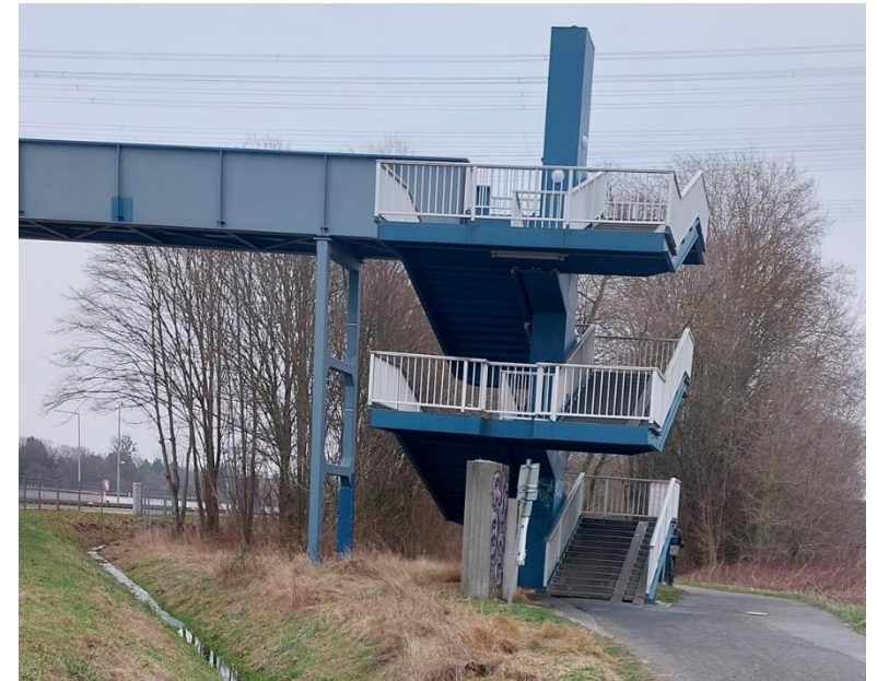
Treppenanlage an der südlichen Mainseite
